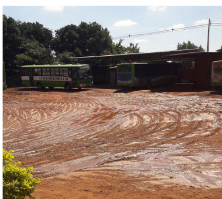
Estado de la parada después de la lluvia.
